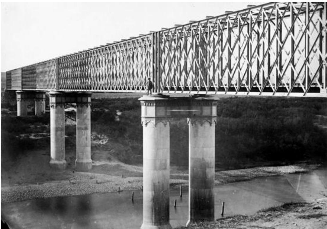
4. Puente sobre el Guadalquivir. Las pilas están formadas por dos pilares de sillería semicirculares y unidos en su coronación por un dintel que ha sido adornado por unos festones en acero. El tablero está formado por dos celosías de acero paralelas que soportan el tablero por donde circula el tren.
