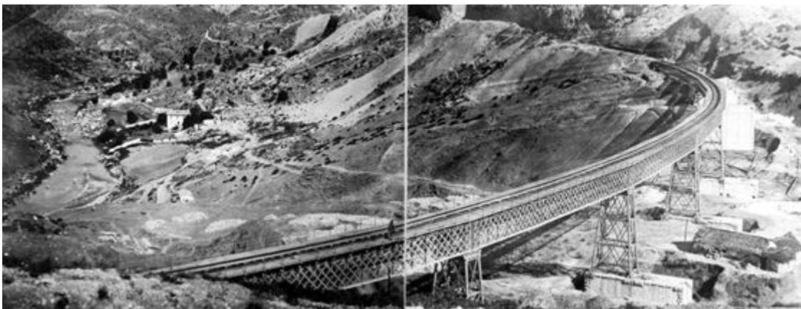
3. Viaducto del Chorro. Hoy desaparecido. Pilas y tablero formados por celosías de acero, material estrella en el siglo XIX, ya que hasta principios del siglo XX no se generalizó el uso del hormigón armado.
